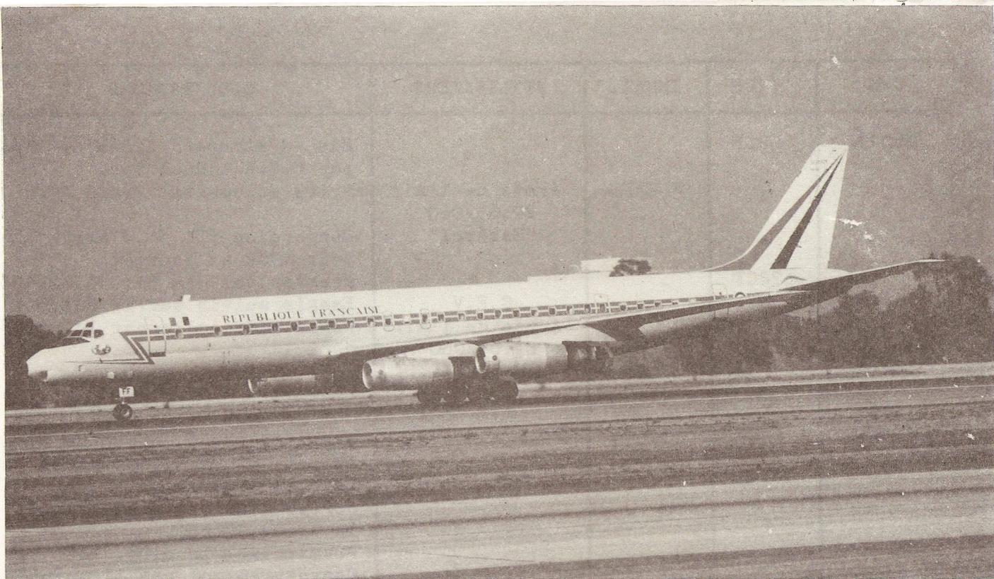
Le DC-8-62CF c/n 46130 F-RAFF à l'atterrissage. On distingue nettement à l'arrière des réacteurs les inverseurs de poussée en pleine action. Photographie X via EMCS. Collection Régis Biaux.
